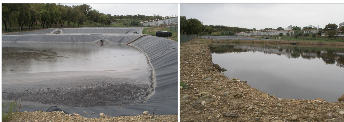
Figura 6– Lagoas do sistema de armazenamento de efluentes pecuários.
